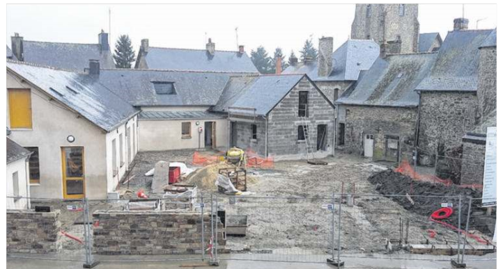
Le préau et le muret du restaurant scolaire, rue des Ecoles, sont en cours de réalisation
